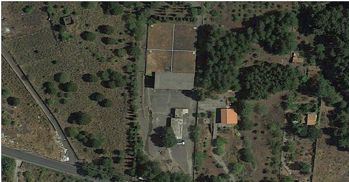
Figura 33 - Ortofoto stato di fatto
