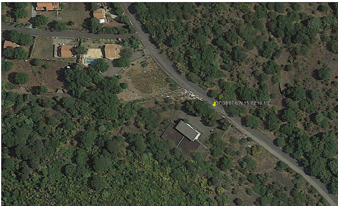
Figura 39 - Ortofoto stato di fatto
