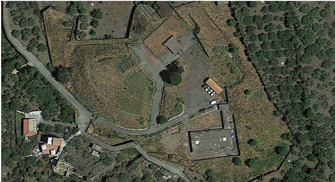
Figura 21 - Ortofoto stato di fatto
