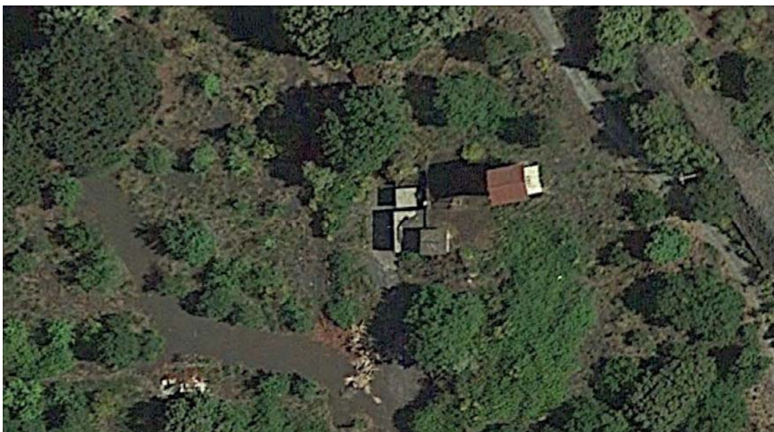
Figura 31 - Ortofoto stato di fatto
