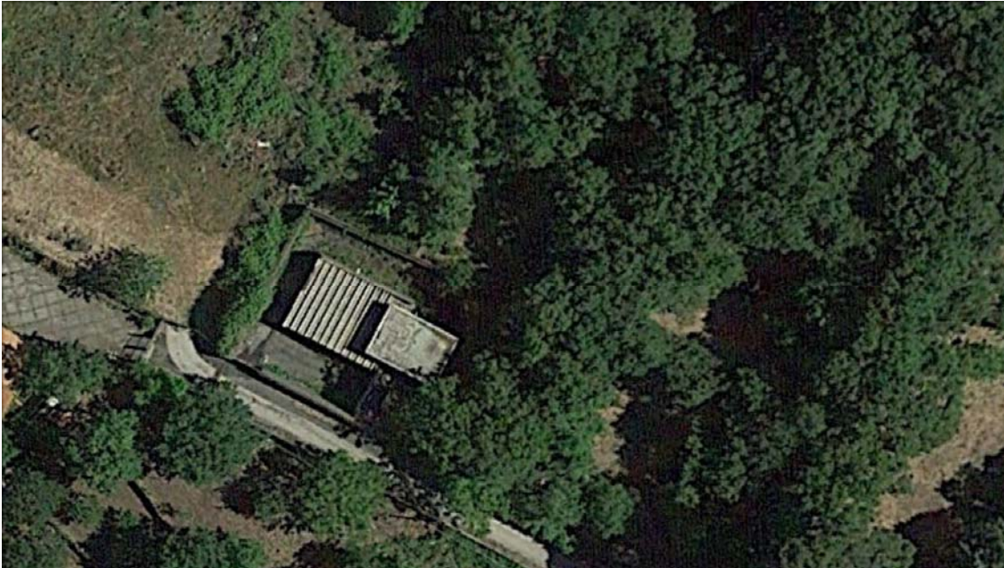
Figura 51 - Ortofoto stato di fatto
