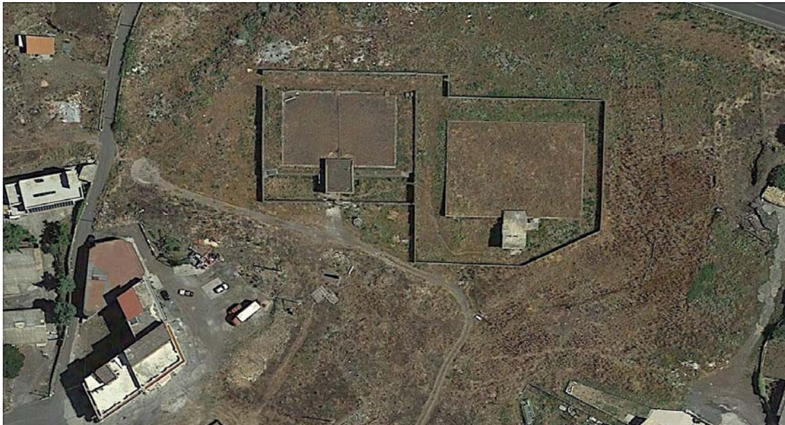
Figura 3 - Ortofoto stato di fatto
