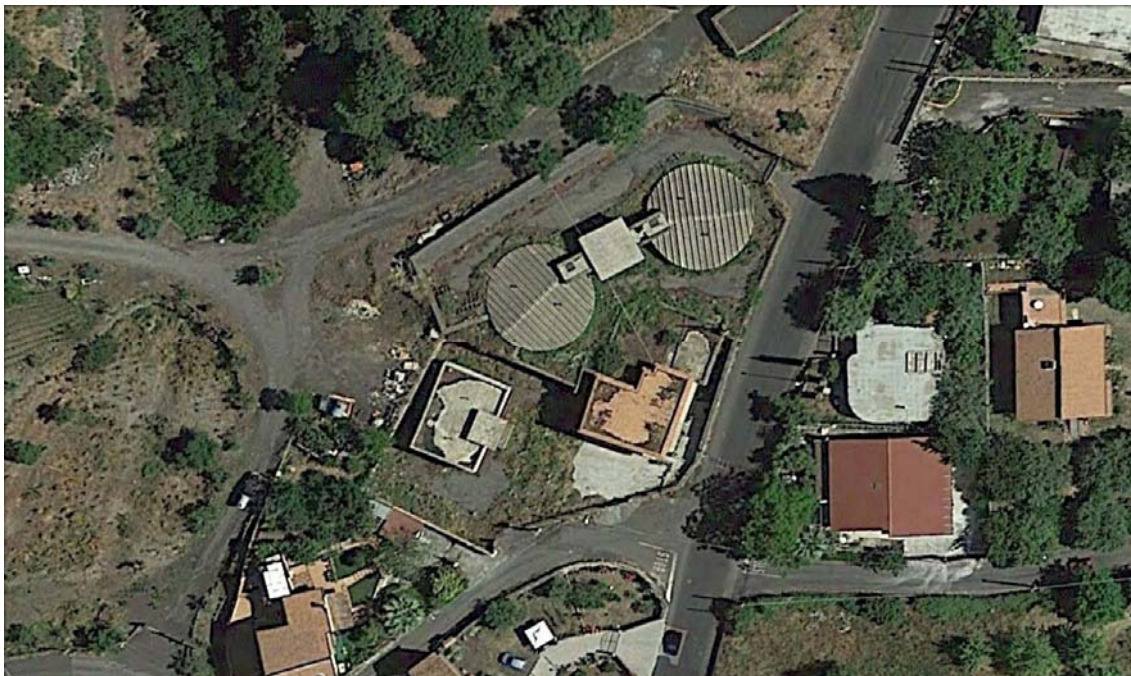
Figura 55 - Ortofoto stato di fatto
