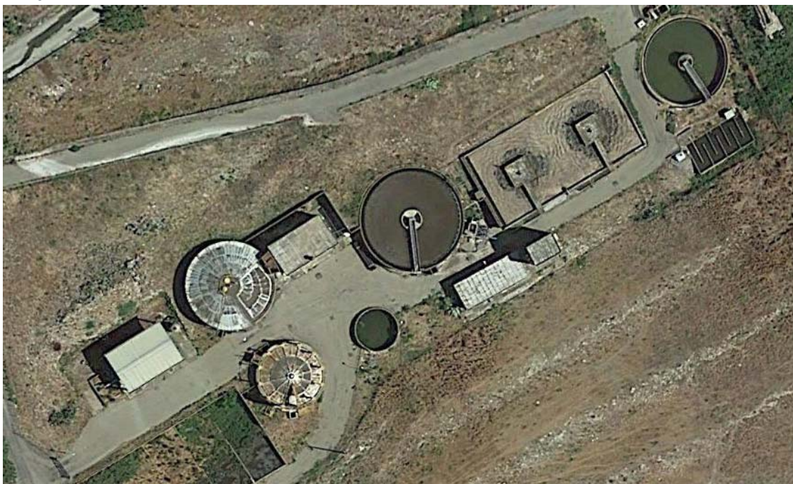
Figura 1 - Ortofoto stato di fatto
