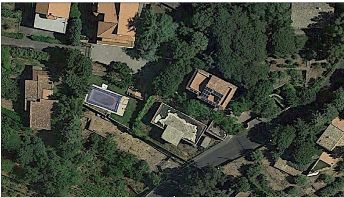
Figura 53 - Ortofoto stato di fatto
