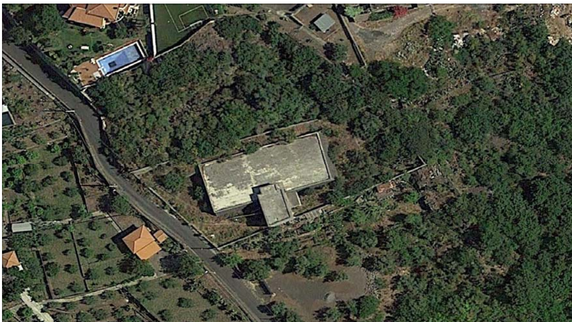
Figura 29 - Ortofoto stato di fatto
