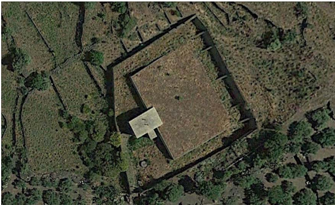
Figura 5 - Ortofoto stato di fatto
