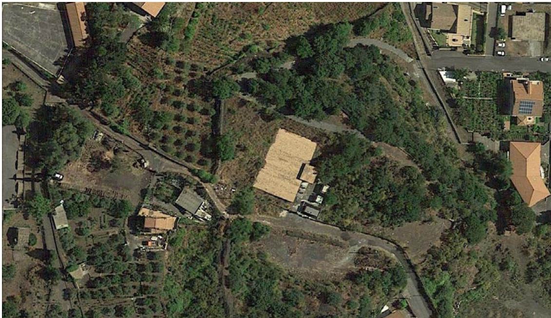
Figura 61 - Ortofoto stato di fatto
