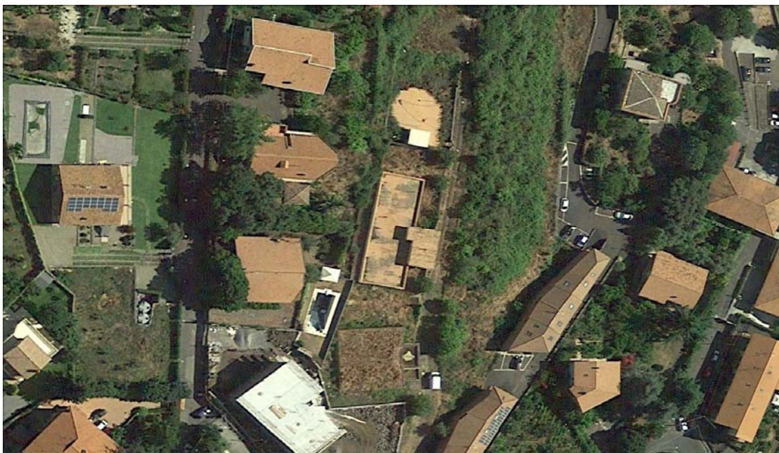
Figura 69 - Ortofoto stato di fatto
