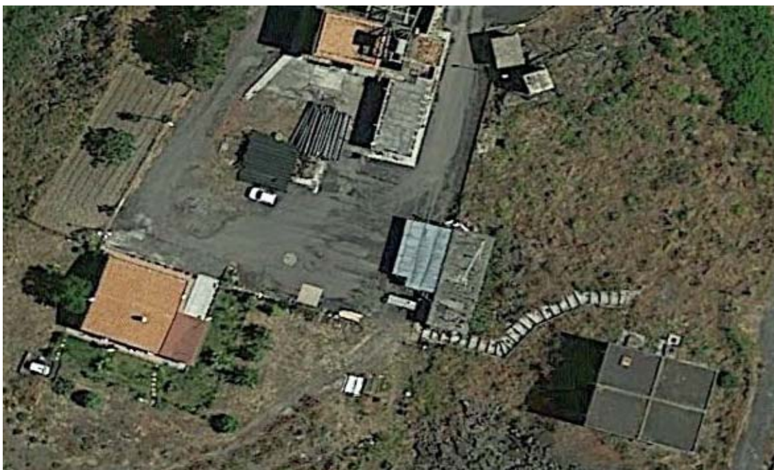
Figura 19 - Ortofoto stato di fatto
